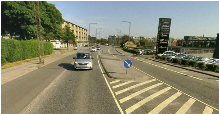
Viborgvej ved Hasle Torv 60 km/t og 16-17.000 ÅDT
