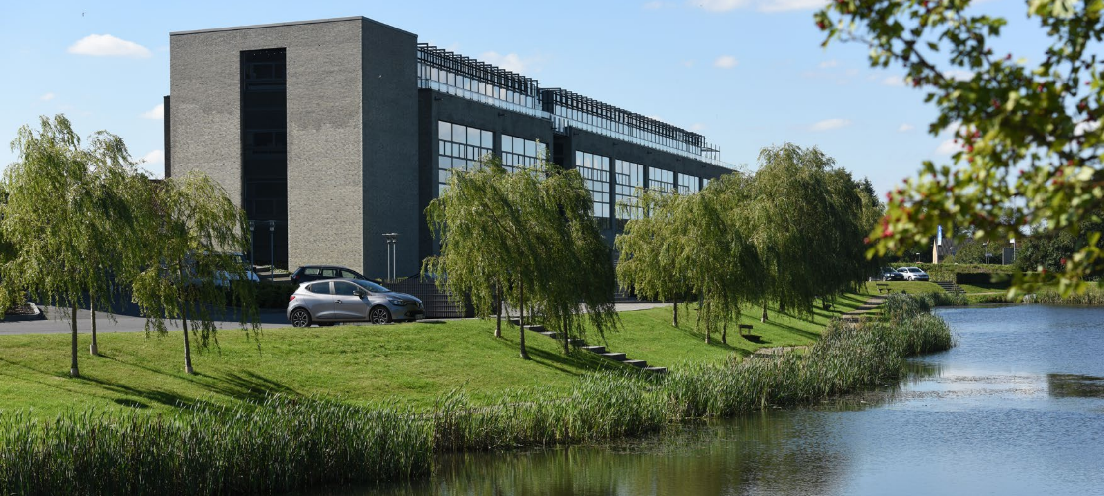
Regnvandsbassin langs erhvervsområde i Tilst.
