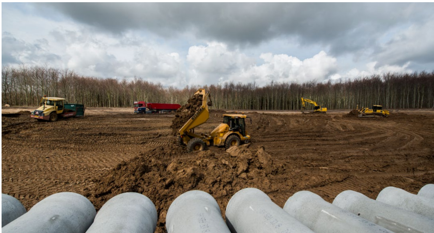
Et nyt regnvandsbassin er under opførelse i udkanten af Beder.
