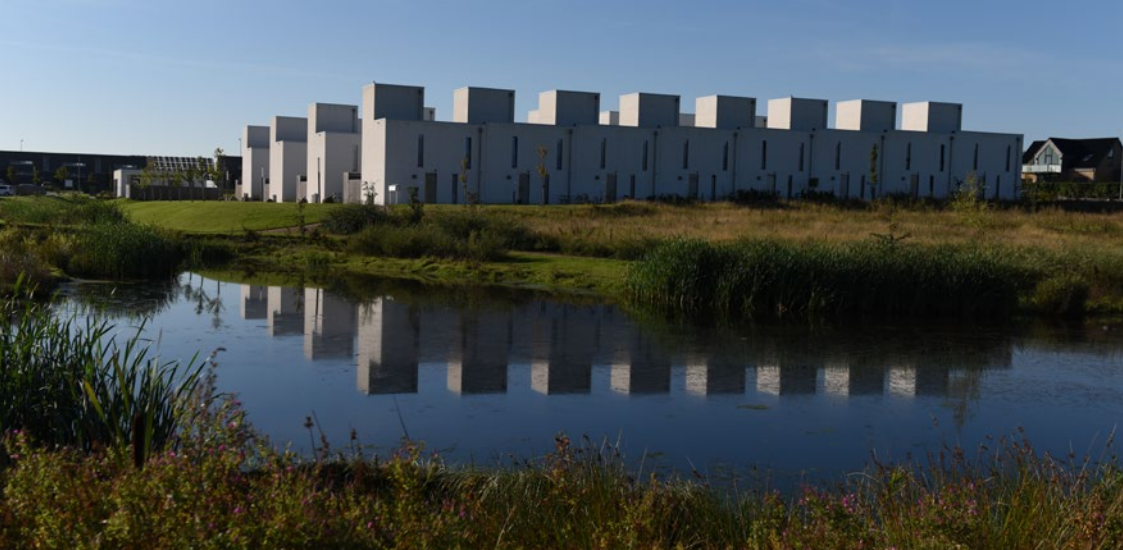
Regnvandsbassin ved nybyggeri i Lystrup.
